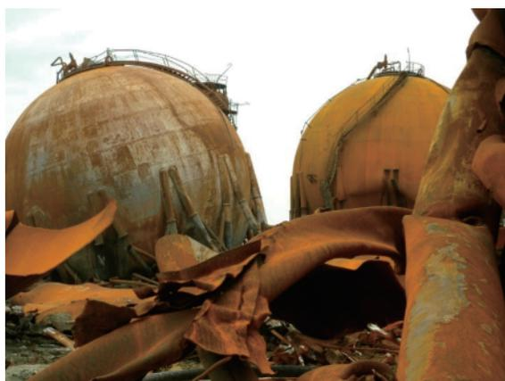
図9 球形ガスタンクの爆発火災による被害状況（筆者撮影）
