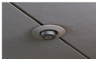
スプリンクラーヘッドは、感熱部を天井ボードより下方に取り付ける。
