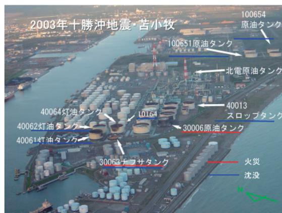
図7 甚大なスロッシング被害を受けた苫小牧市内の製油所（消防研究所撮影に追記）
