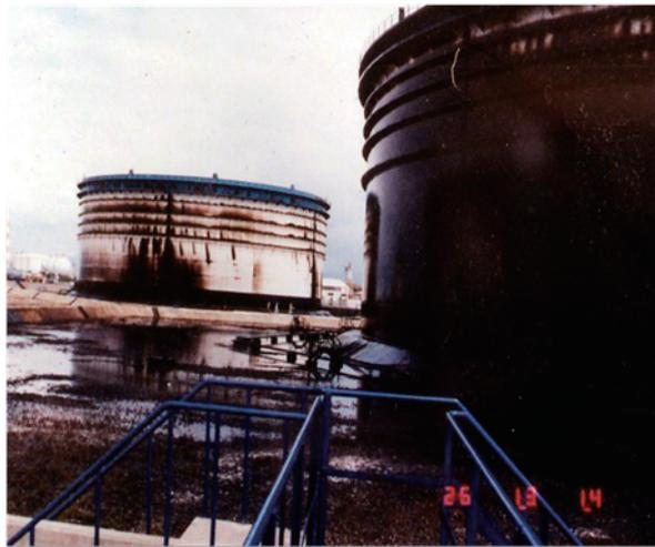
図5 新潟県で認められたスロッシングによる大量の原油の溢流状況（消防研究所撮影）
