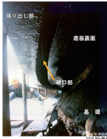
図4 1978年宮城県沖地震での油流出タンクの隅角部の状況(仙台市消防局提供)
