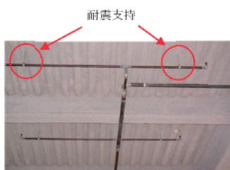
横引き配管に適当な間隔で耐震支持を設ける。
