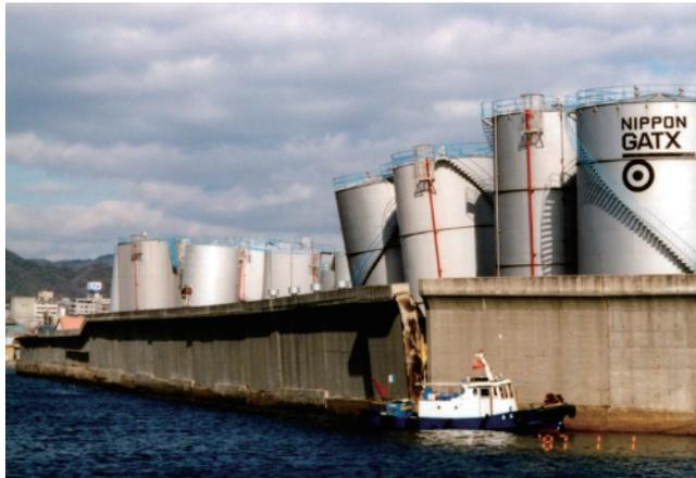
図6 1995年兵庫県南部地震での液状化によるタンクの傾斜（筆者撮影）
