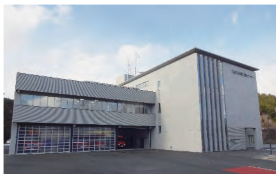
写真11 高台に完成した防災センター
