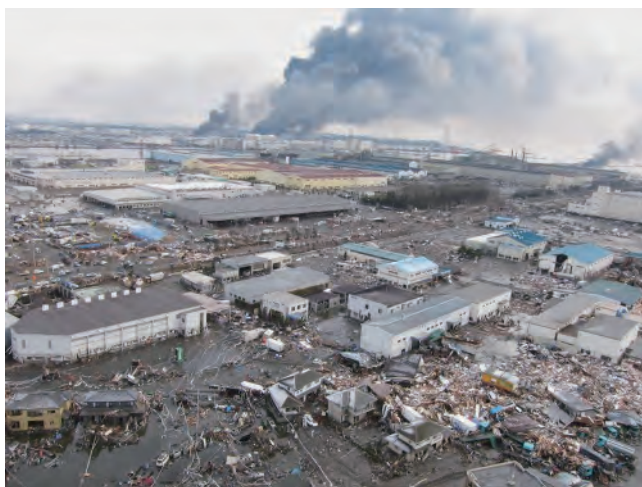
写真2 津波被害 / 石油コンビナート地区（宮城野区）
