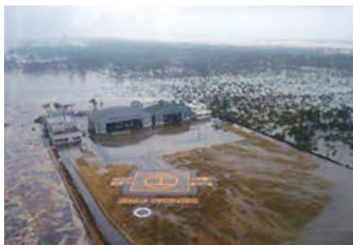
津波で被害を受けた基地
