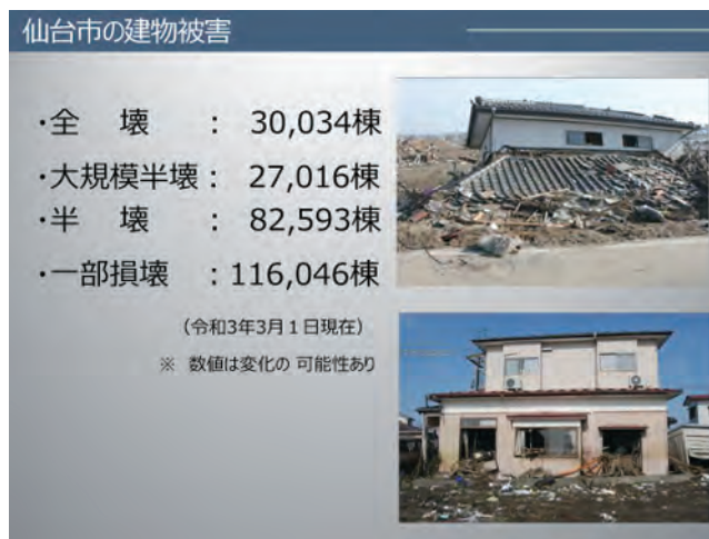
図5 仙台市の建物被害
