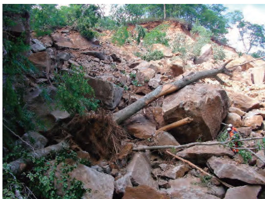
図11 2008年に発生した岩盤崩落の現場の様子
