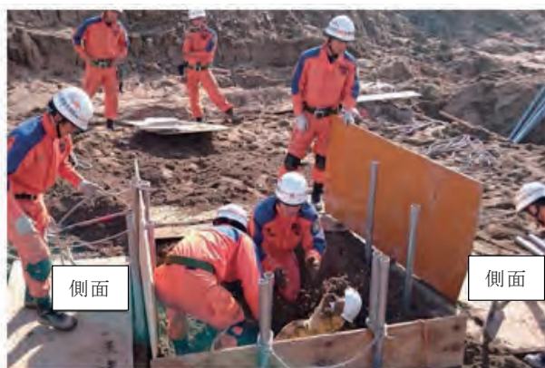
図4 及び写真5 土留め板の設定
