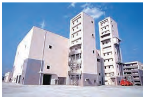
写真3 第1訓練棟 (高層訓練塔、立て坑救助施設、都市型訓練施設、フリークライミング、火災室、防災センター、可動式模擬家屋等)
