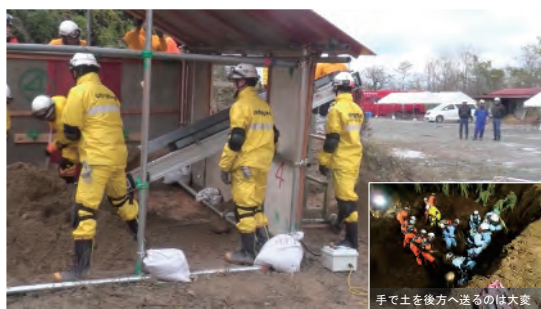
可搬型ベルトコンベアによる土砂排出（土砂を持ち上げずに滑らすようにコンベアに乗せると率的で（協力：山形市消防本部、山形県内各消防本部） ※100V電源で動く重さ50kgのベルトコンベアは建機レンタルでも取扱あり
