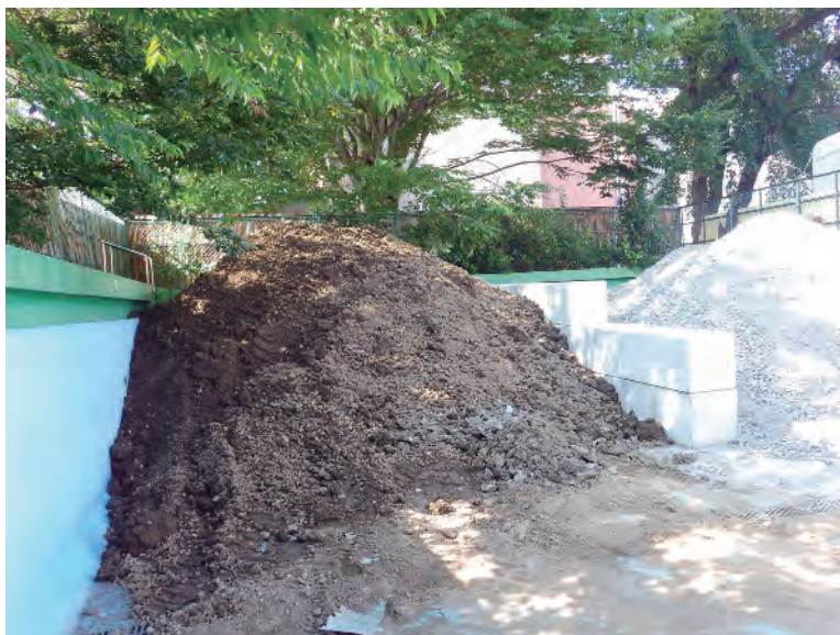
土砂ブース（土砂量は45立米）
