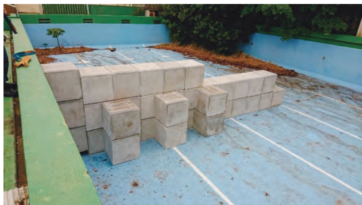
ブース分け（土砂の種類を分けるため）のための土留め設置
