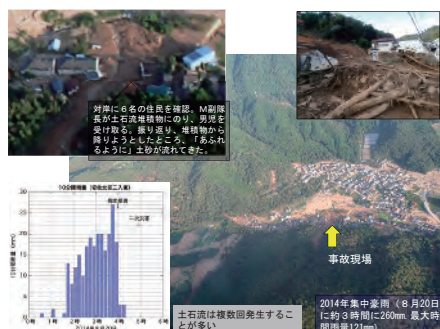
図1 2014年に発生した土石流による殉職災害の状況
