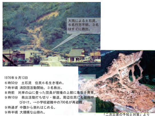
図6 1976年に発生した地すべりによる二次災害を防ぎ得た状況
