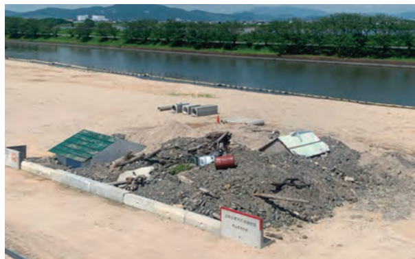
土砂災害対応訓練施設
