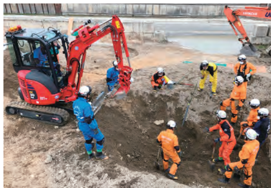
写真15 重機連携訓練
