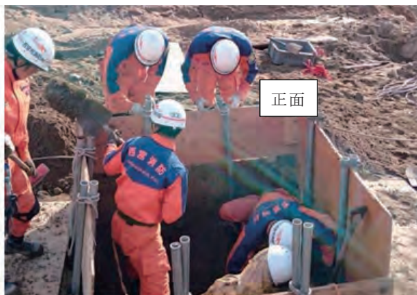
図6及び写真7 ロケット型土留め板（追加用）を設定
