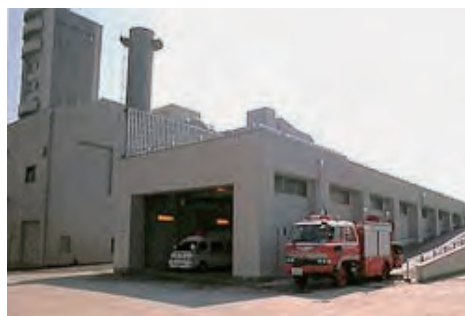
写真4 第2訓練棟 (地下街訓練施設、トンネル訓練施設、迷路室、高速道路訓練施設等)
