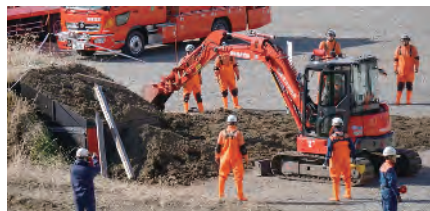
写真15 県内消防機関による重機取扱訓練
