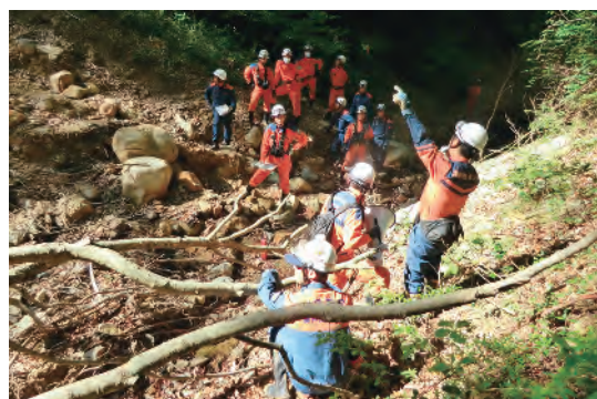
図18 実際に土砂崩れがあった場所での安全管理にかかる研修の事例
