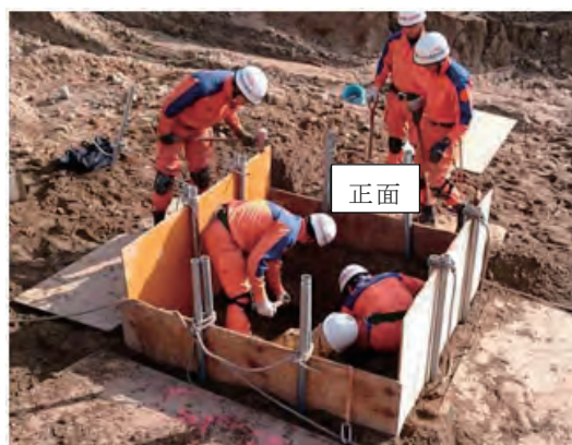
図5 及び写真6 ロケット型土留め板を設定
