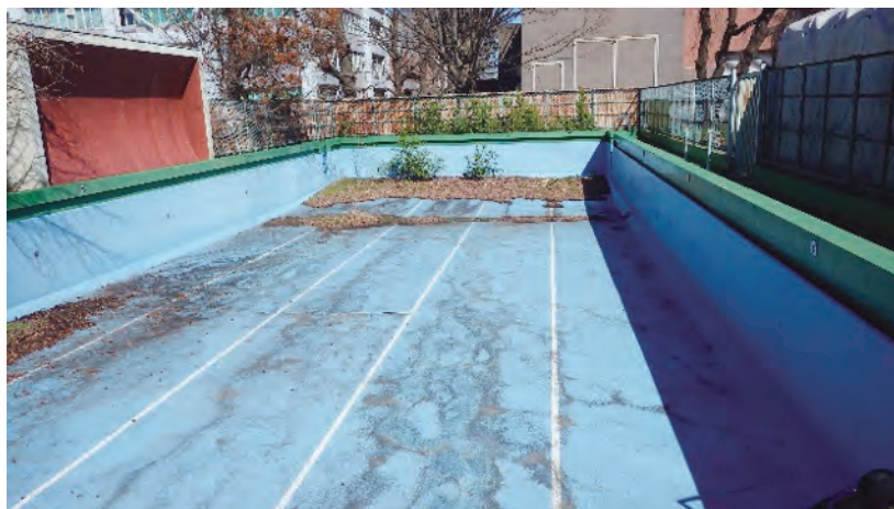
使用されていなかったプール
