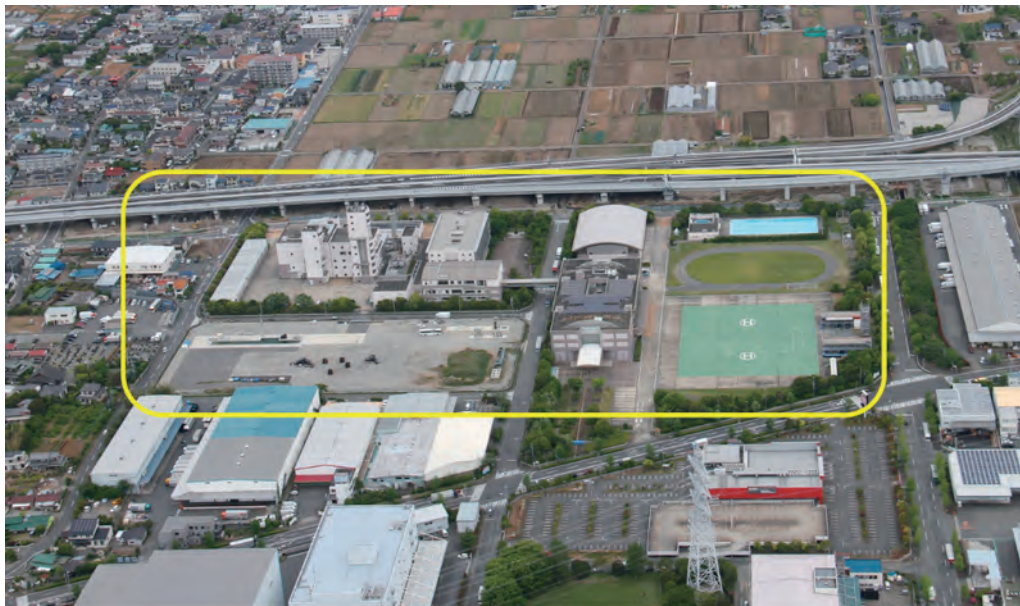
写真1 神奈川県消防学校空撮写真 手前左側が災害救助訓練施設 東西に伸びるのは新東名高速道路
