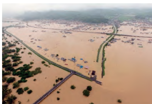
図1 浸水被害の状況（平成30年7月豪雨）
