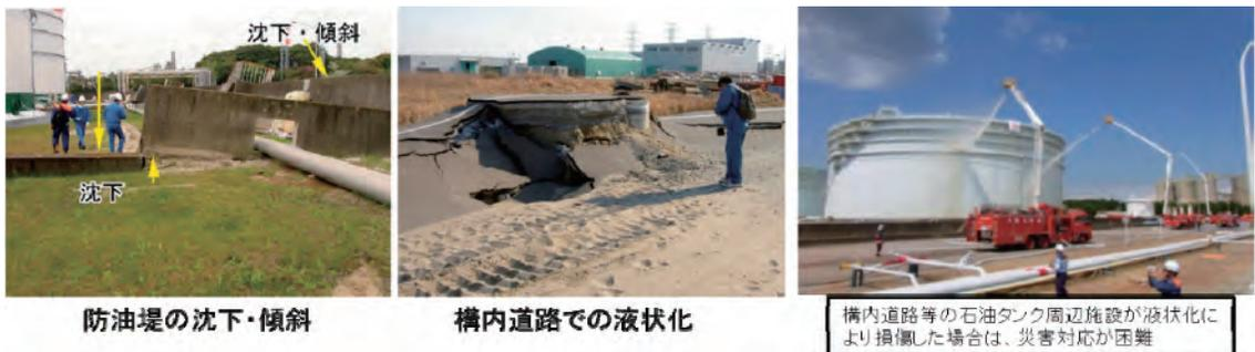
図1 地震時の石油タンク周辺施設での液状化について（SIPでは、Eーディフェンス等を用いた大規模実験等により、巨大地震を想定した影響を分析・検証し石油タンクの安全性評価を行うとともに、石油タンク周辺施設の効果的な液状化対応技術を開発する。）
