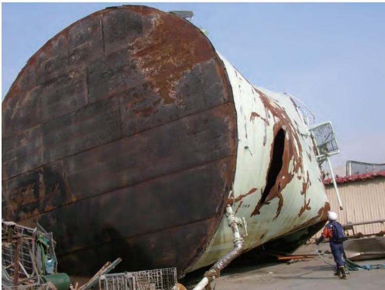
図1 平成23（2011）年東北地方太平洋沖地震の際の石油タンクの津波被害（気仙沼市）
