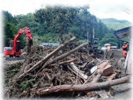
写真⑦ 重機による障害物の除去
