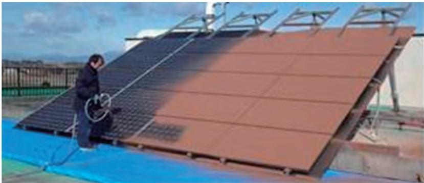
図6 4.8kW太陽電池アレイ発電抑制120秒後
