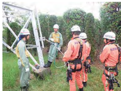
写真5 鉄塔レールへのラビット取付風景
