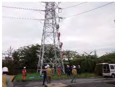
写真6 鉄塔昇降訓練風景
