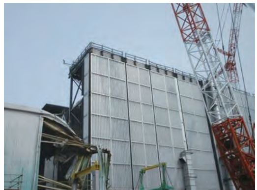
3号機建て屋の状況（現在）
