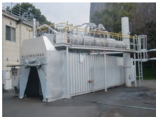
写真1 実火災体験型訓練施設
